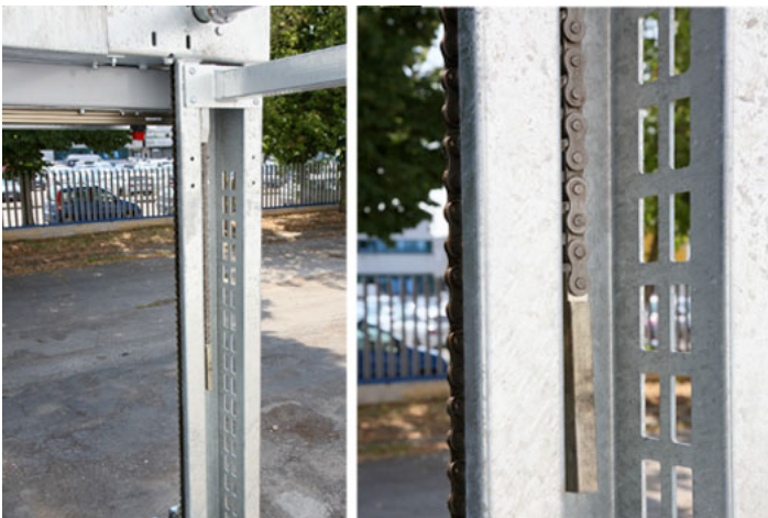
Деталь соединения между поршнем и цепью движения.
