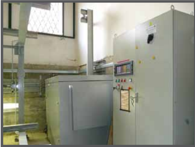
Рис. 4: Блок управления гидравлическим подъемником с защитным корпусом и пультом управления, при помощи которого могут выполняться функции контроля, предупреждения об опасности и технического обслуживания системы.
