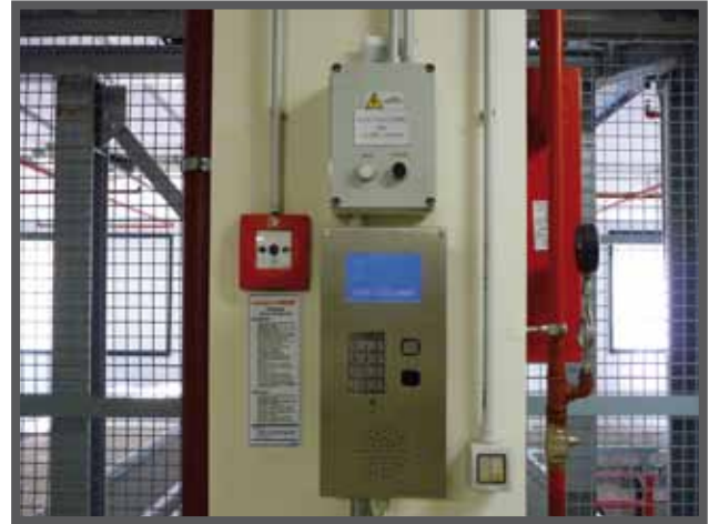
Рис. 5: Пульт управления, используемый в качестве информационного табло, для ввода кодов доступа для сдачи и получения автомобиля с парковки.
