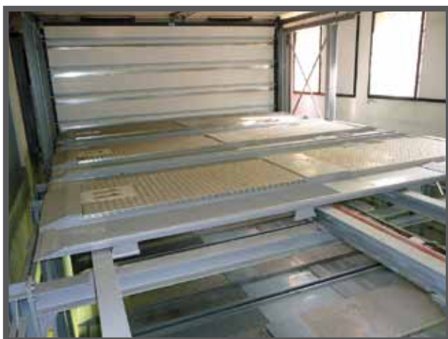
Рис. 3: Область хранения платформ для автомобилей, расположенная рядом с входом. Раздвижная дверь закрыта.
