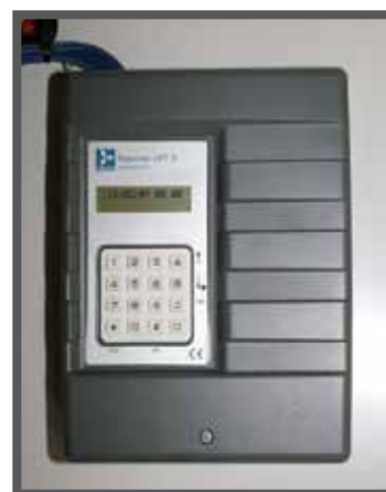
Телефонный аппарат, расположенный внутри щита питания, может повторно набирать до семи телефонных номеров, причем для повторного
